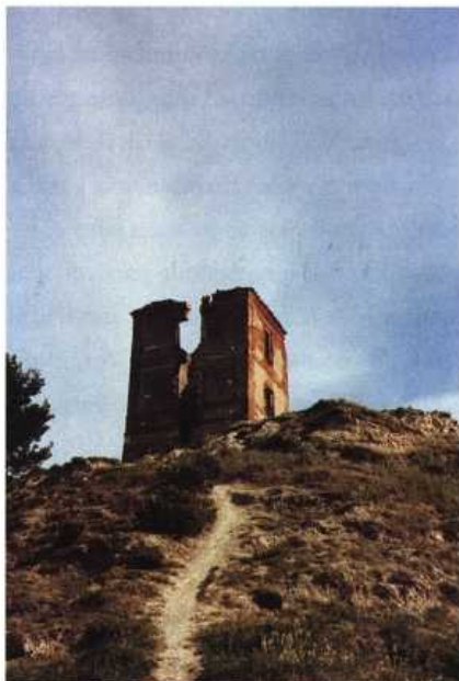
ESTADO ACTUAL DE LA TORRE N.º 21 DE LA LÍNEA DE IRÚN EN TARIEGO, PALENCIA.
