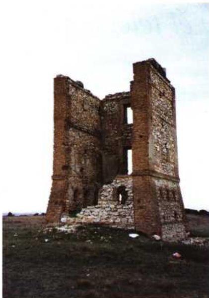
ESTADO ACTUAL DE LA TORRE DEL TELÉGRAFO ÓPTICO, EN ARGANDA DEL REY, MADRID.
