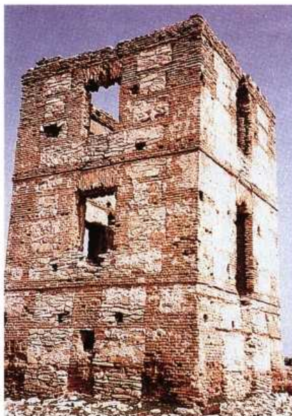
TORRE DE MONTERREDONDO, N.º 5 DE LA LÍNEA DE IRÚN.
