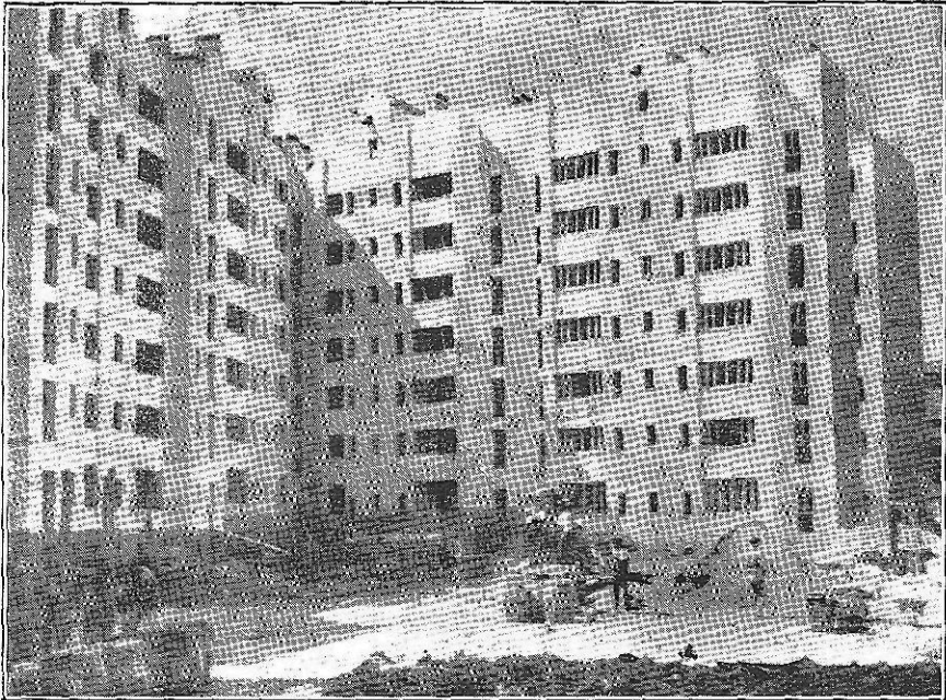
Fot. 13.—Construcción de tres casas del tipo A y cinco del tipo B en la calle de Santa Engracia. Un aspecto de los patios interiores en 1.º de julio de 1929.
